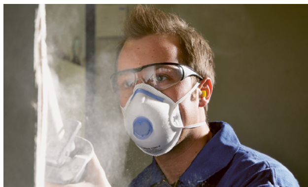
Fig. 4: les demi-masques de la classe FFP2 ou P2 constituent le standard pour de nombreux travaux.
